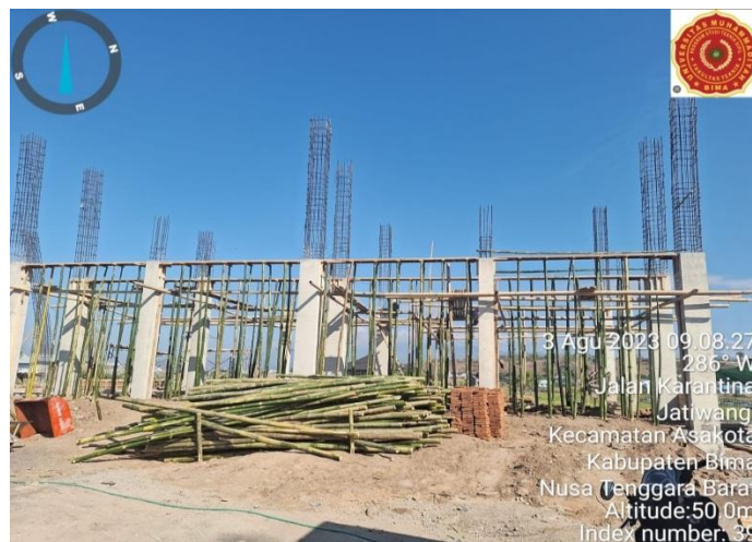
Gambar 8. Pendampingan pengawasan pekerjaan konstruksi
